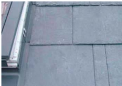
Figur 1. Korrekt afslutning med indskudt skiferstykke. Bemærk, at fastgørelse med kobbersøm holder længere (end fx rustfri søm) og så kan de fjernes med sømudtrækker.
