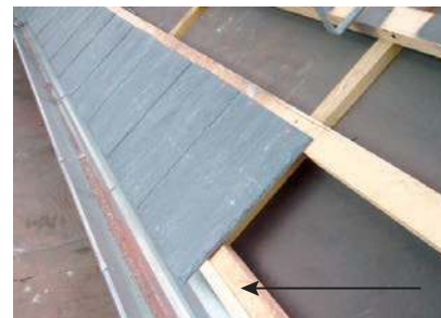
Figur 3. Pilen viser "skiferlisten", som monteres ved tagfod (og tagrygning) for at undgå at skiferstenene vipper.
